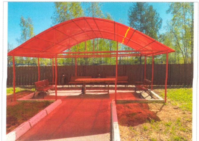
Фото №4 – Зоны отдыха на прилегающей территории.
