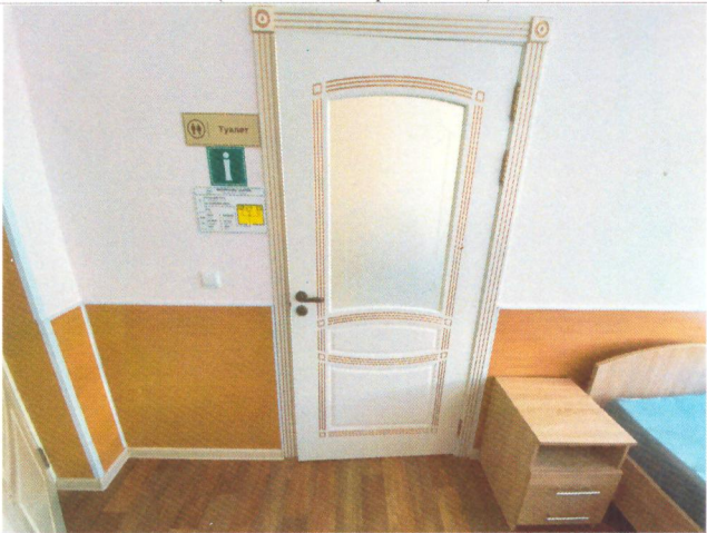
Фото №29 – Санитарно-гигиенические помещения
