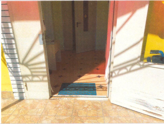
Фото №13 – Входная дверь.
