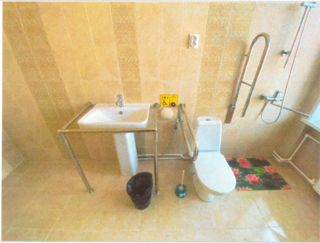
Фото №31 – Санитарно-гигиенические помещения
