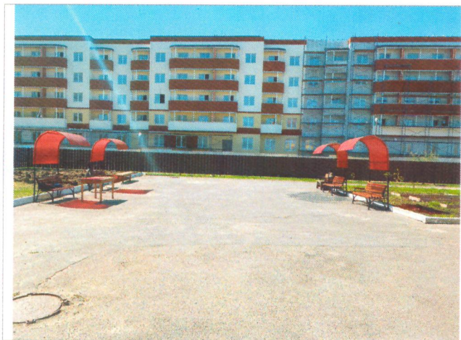
Фото №5 – Зоны отдыха на прилегающей территории.
