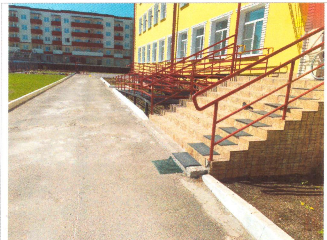
Фото №8 – Наружная входная лестница.
