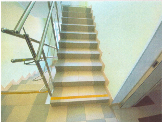
Фото №17 – Пути движения внутри здания (лестницы)
