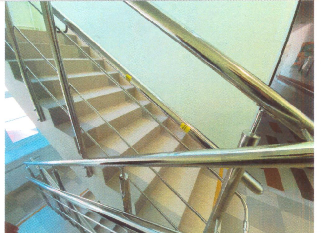
Фото №18 – Пути движения внутри здания (лестницы)
