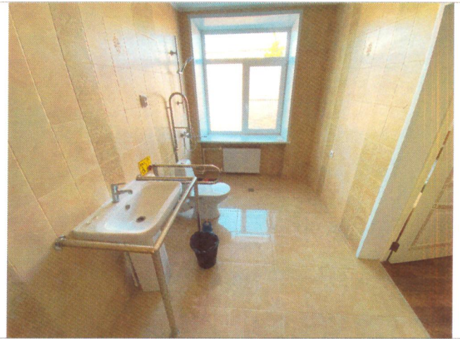
Фото №32 – Санитарно-гигиенические помещения
