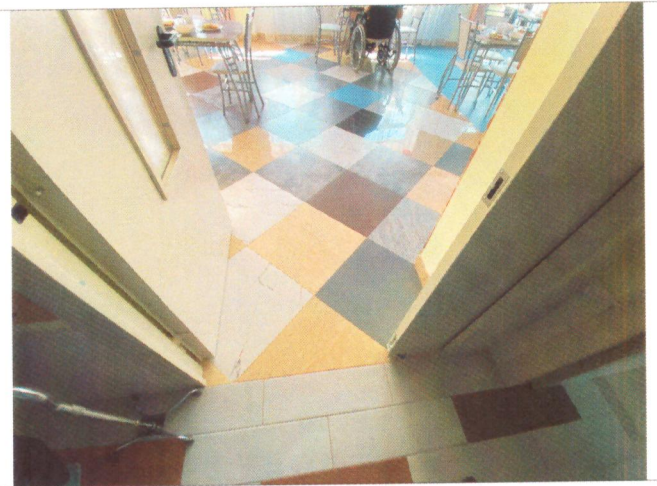
Фото №22 – Пути движения внутри здания (двери)
