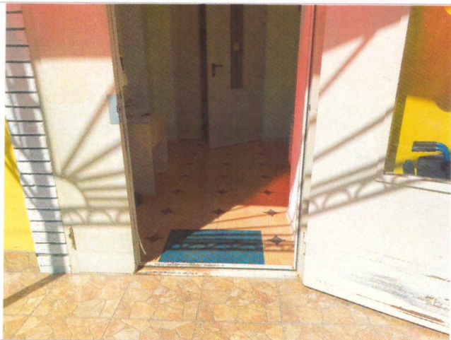
Фото №13—Входная дверь.
