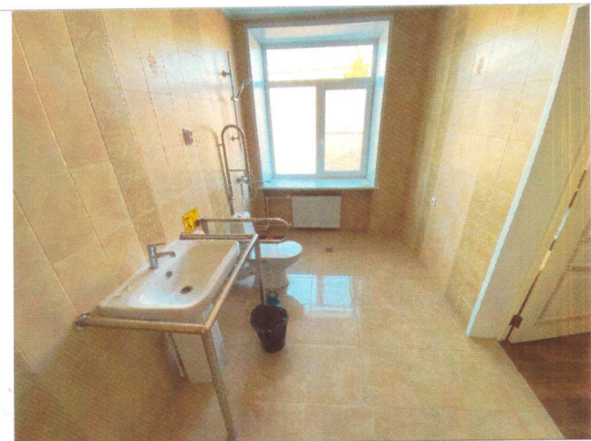
Фото №32 – Санитарно-гигиенические помещения
