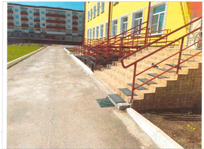
Фото №8 – Наружная входная лестница.
