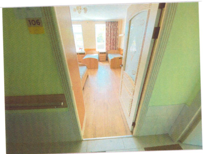
Фото №25 – Пути движения внутри здания (двери)
