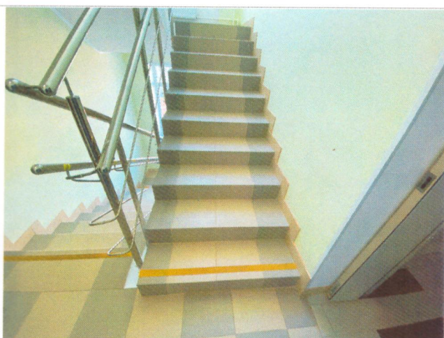
Фото №17 – Пути движения внутри здания (лестницы)
