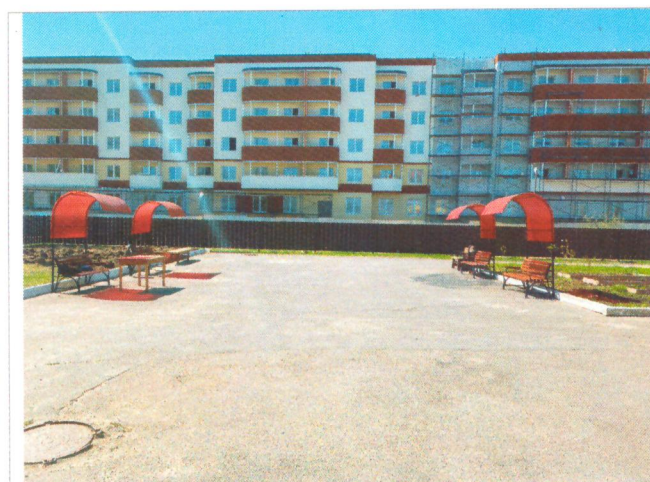
Фото №5 – Зоны отдыха на прилегающей территории.
