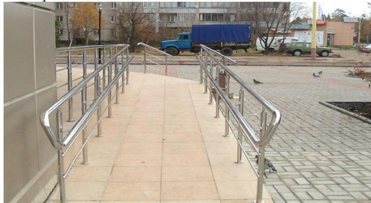
Можно выделить дополнительный поручень внутри пандуса на расстоянии 900 мм (это оптимальное расстояние для удобного перехватывания обеими руками) от одного из поручней, чтобы создать удобную зону для подъема инвалидов на колясках.
