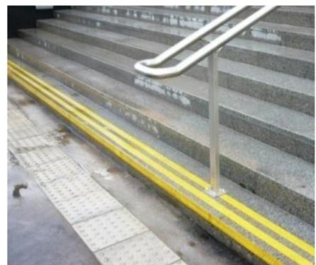
Рекомендовать выполнить контрастную маркировку ступеней, в том числе установку противоскользящих покрытий по краю ступени. При отсутствии маркировки – доступность для слепых
