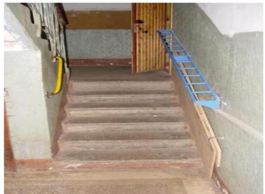
Также возможна установка откидного пандуса из швеллеров. Но при этом очень важно учитывать вес создаваемой конструкции, так как его вам часто придётся откидывать и складывать к стене. Поэтому оптимально делать их из алюминиевых сплавов, а также один из швеллеров лучше сделать стационарным
