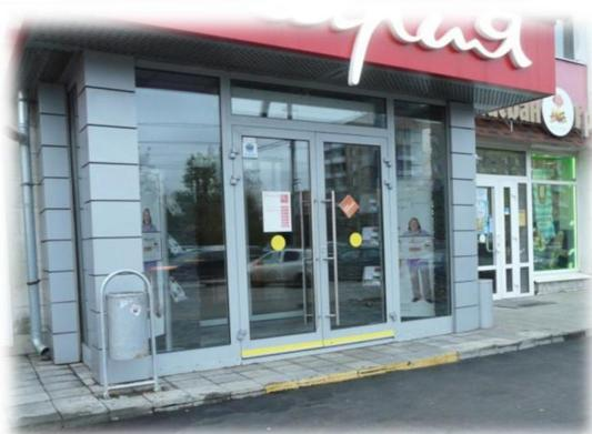
Рекомендовать сгладить площадку пологим пандусом. При затесненной застройке и невозможности устройства пандуса край площадки должен быть выделен контрастной полосой.
