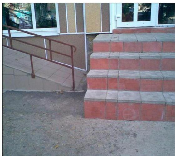
На фотографии продемонстрирован пандус, пользование которым инвалидами опасно для их жизни. Прежде всего, это отсутствие с одной стороны ограждения и поручня, также ненормативный уклон, отсутствие в середине пролёта площадки для отдыха и не сплошное покрытия поверхности пандуса. Подняться по такому пандусу инвалид на коляске просто не сможет, а если попытается спуститься, то это гарантированно травмами.
