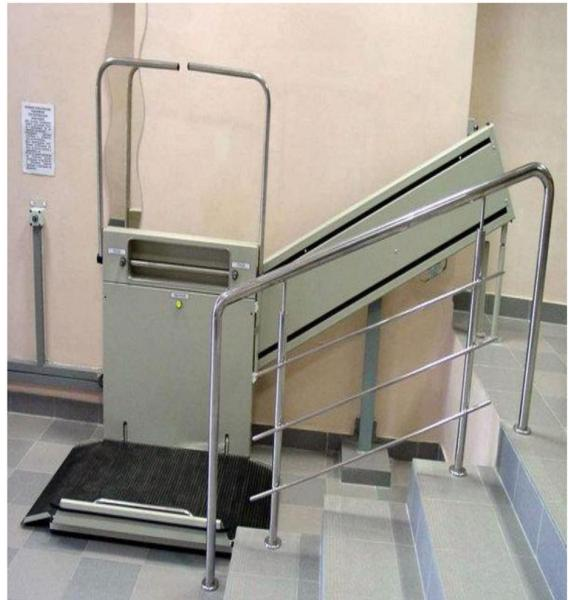
Подъемники могут использоваться как внутри, так и снаружи зданий. При необходимости он может оснащаться шлагбаумом или шахтой с дверями. При разнице отметок до 1,8 м обычно используются открытые платформы. Подъемники с закрытыми кабинами внешне напоминают обычные лифты.
