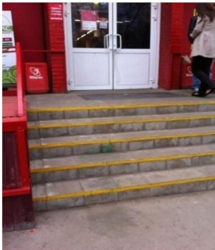
СП 59.13330 п. 5.2.31 Возможно применение для ориентации и помощи слепым и слабовидящим защитного углового профиля на каждой ступени по ширине марша. Материал должен быть шириной 0,05 - 0,065 м на проступи и 0,03 - 0,055 м на подступенке. Он должен визуально контрастировать с остальной поверхностью ступени
