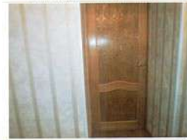
Фото №18 - Пути движения внутри здания (дверь)
