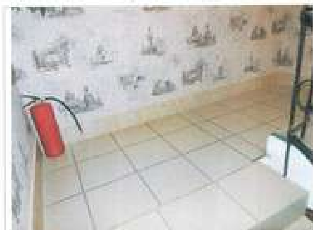
Фото №15 - Пути движения внутри здания (лестница)
