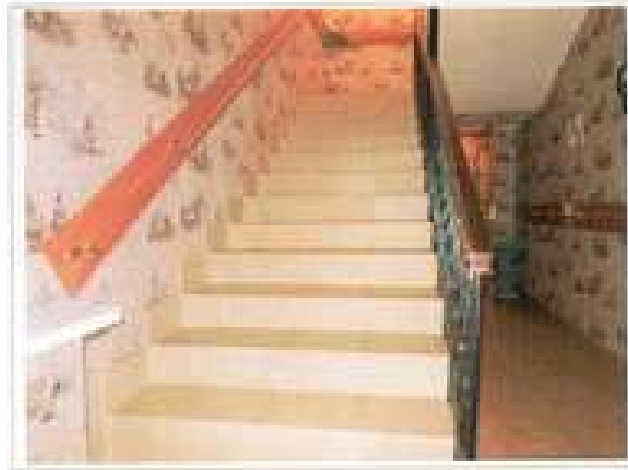
Фото №14 - Пути движения внутри здания (лестница)
