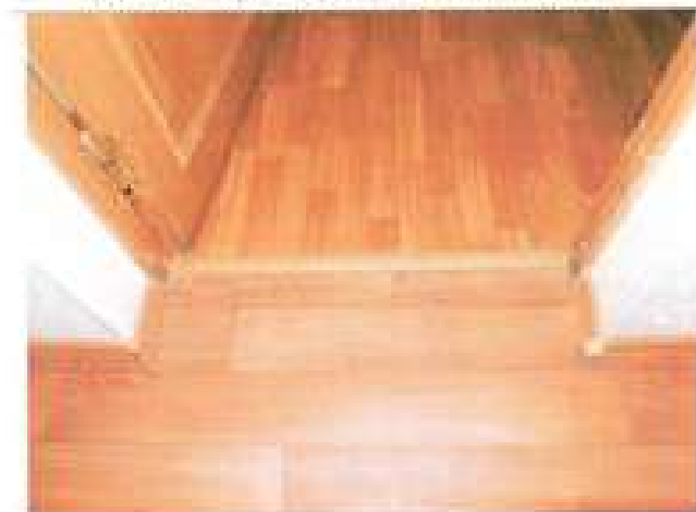
Фото №17 - Пути движения внутри здания (лестница)
