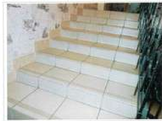
Фото №16 - Пути движения внутри здания (лестница)
