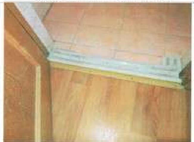
Фото №22 - Пути движения внутри здания (дверь)
