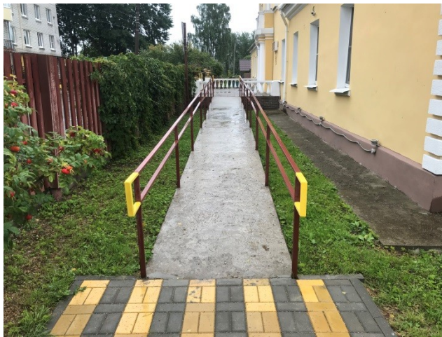
Фото №8 – Пандус, ведущий к входной площадке главного входа.
