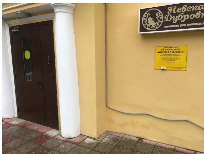
Фото №9 – Входная площадка главного входа.
