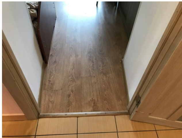
Фото №20 – Пути движения внутри здания (двери)
