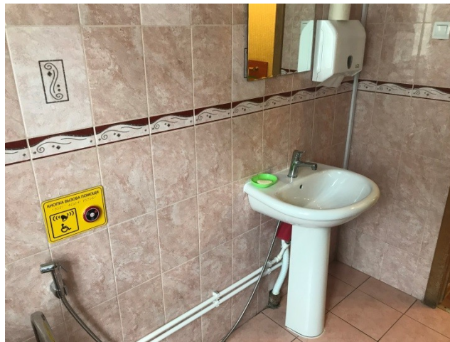
Фото №38 – Санитарно-гигиенические помещения
