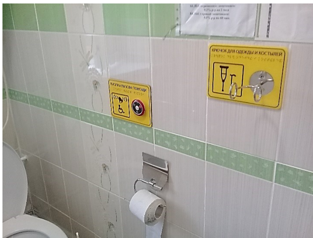
Фото №42 – Санитарно-гигиенические помещения
