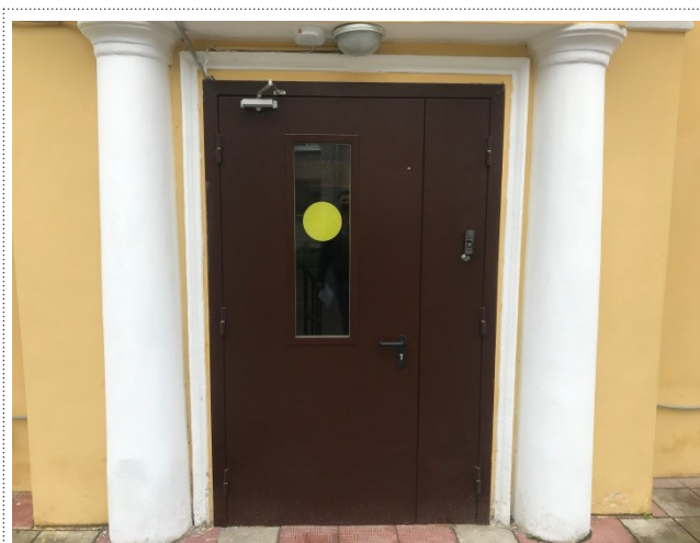
Фото №10 – Внешняя входная дверь
