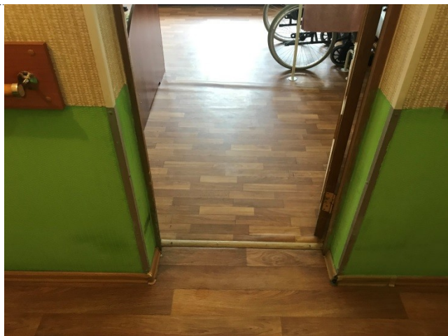
Фото №23 – Пути движения внутри здания (двери)
