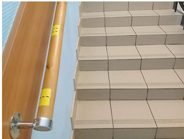
Фото №26 – Пути движения внутри здания (лестницы)
