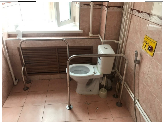
Фото №37– Санитарно-гигиенические помещения
