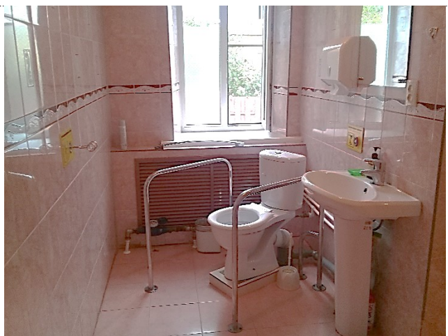
Фото №39– Санитарно-гигиенические помещения
