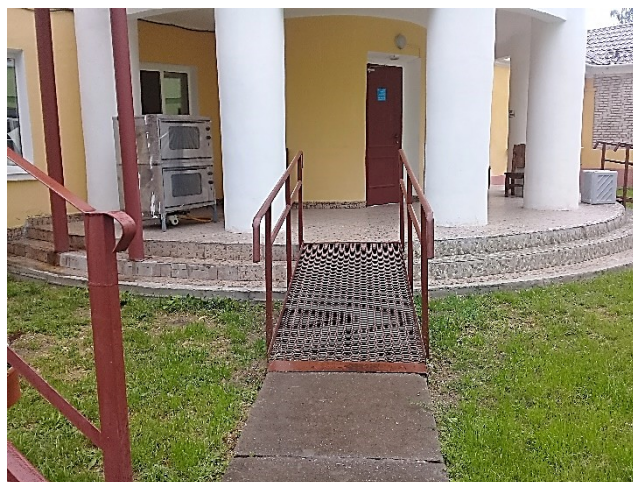
Фото №46 – Запасной выход
