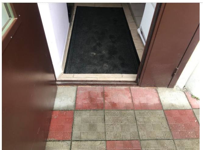
Фото №11 – Внешняя входная дверь
