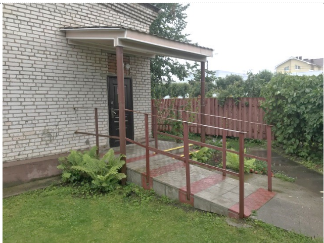
Фото №47– Запасной выход
